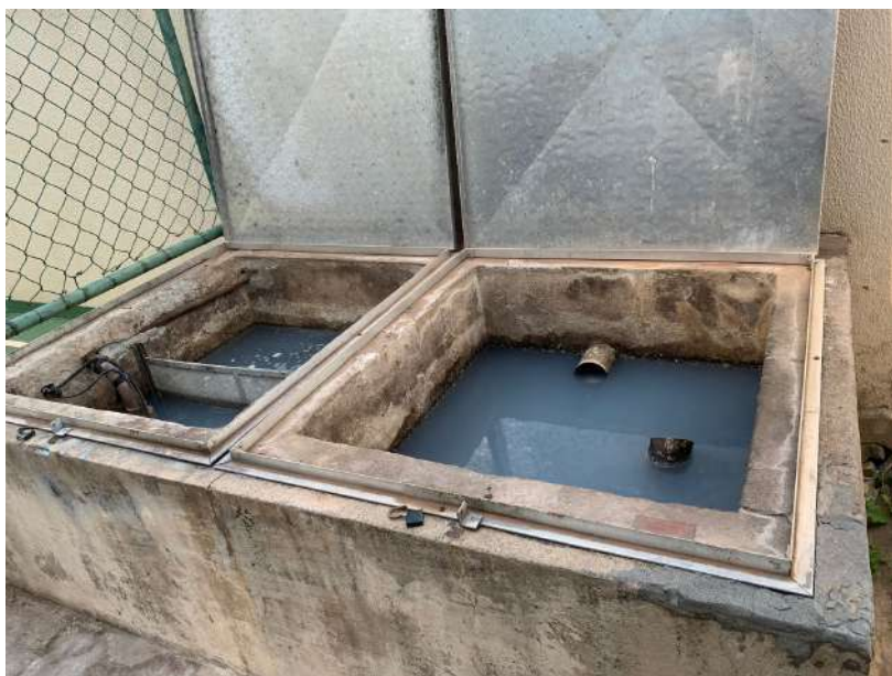
Figura 20- Tanques de filtração. Fonte: Acervo pessoal
