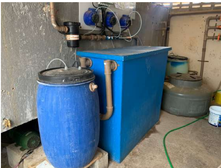
Figura 21- Tratamento de água cinza. Fonte: Acervo pessoal
