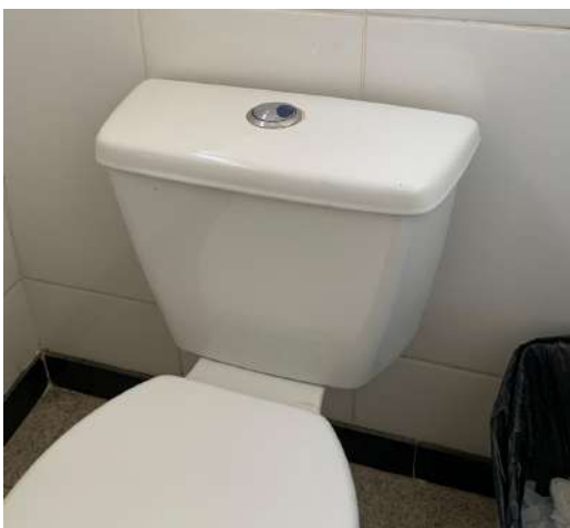
Figura 29-Descarga de duplo acionamento. Fonte: Acervo pessoal
