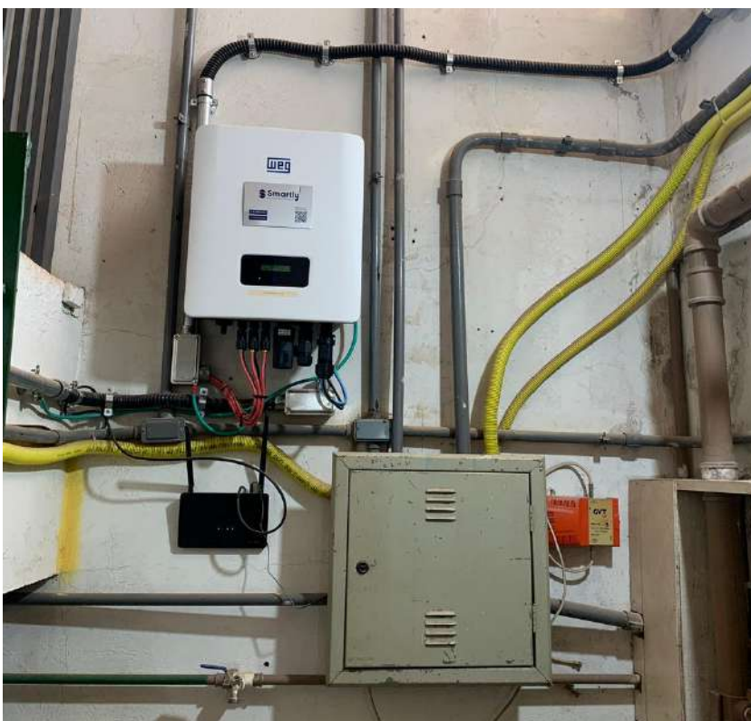
Figura 26 -Aparelho inversor. Fonte: Acervo pessoal
