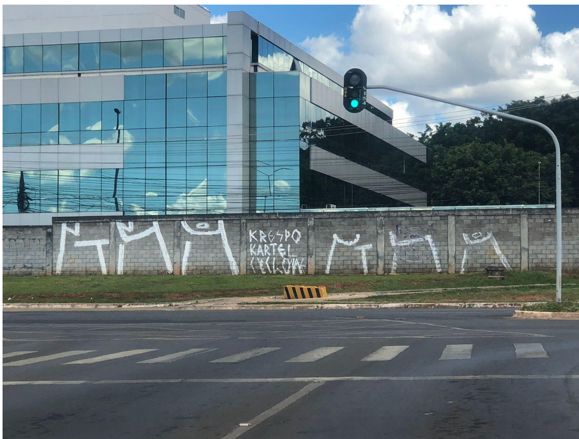
Pixações em muro da Asa Norte, região nobre do Distrito Federal. / Fonte: Autora.
