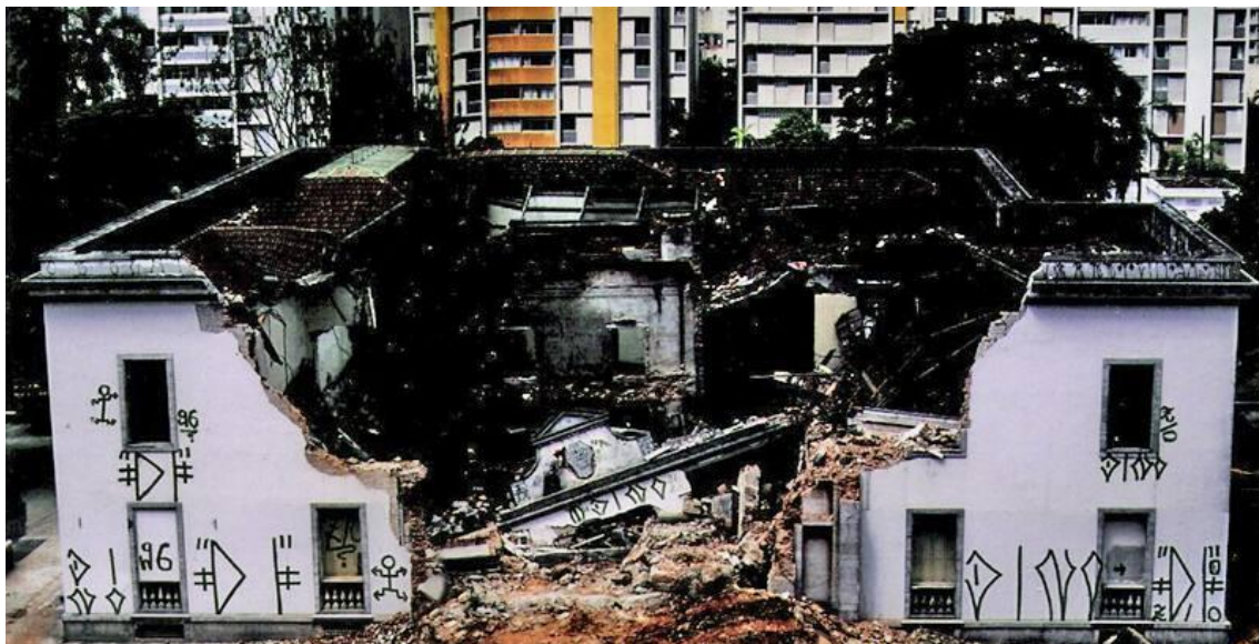
Demolição da Mansão Matarazzo em 1996, com pixações de Di e Dino em sua fachada. / Fonte: Autor desconhecido.
