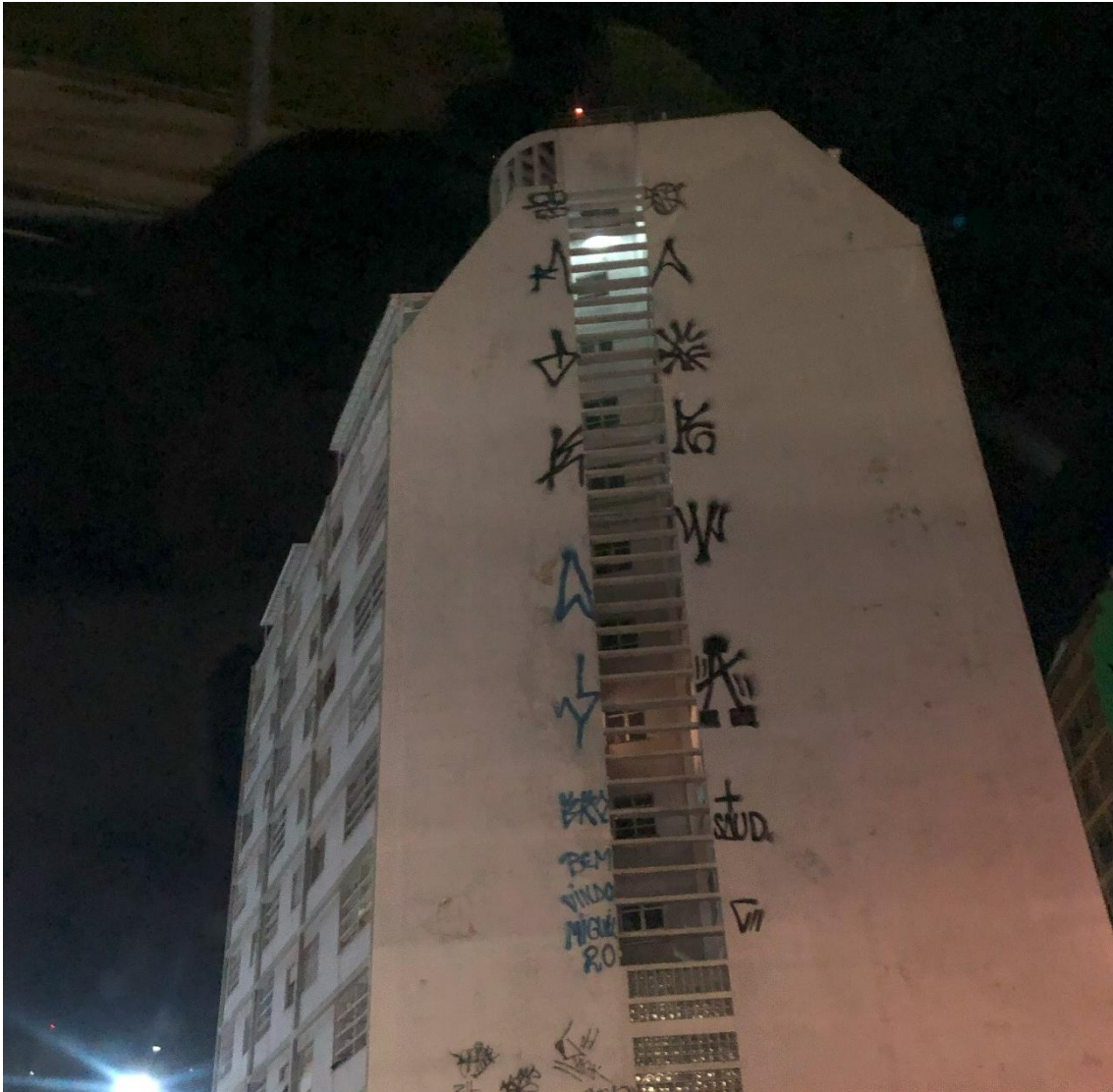
Pixações feitas durante escalada em brises de edifício de São Paulo. / Fonte: Autora.
