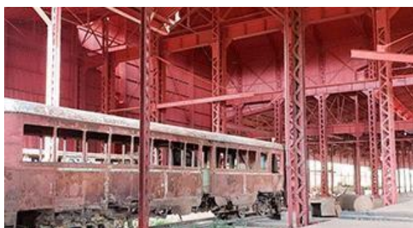
Figura 46: Imagem interna oficina de máquinas de 2015.
