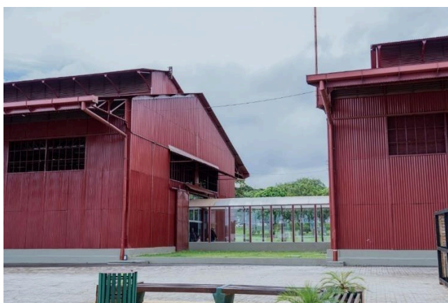
Figura 30: “Corredor aberto” ligando os dois galpões, resultado da reforma.
