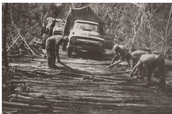
Figura 14: Construção da rodovia dos Estados de Rondônia e Mato Grosso
