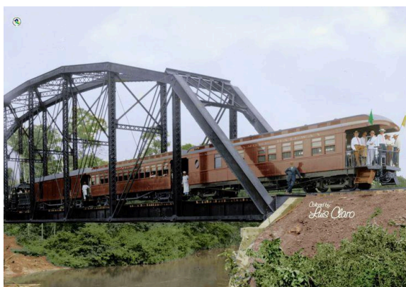
Figura 13: Trem inaugural com passageiros em ponte sobre rio Jaci-Paraná, seguindo em direção a Porto Velho, por ocasião da inauguração da Ferrovia E.F.M-M.
