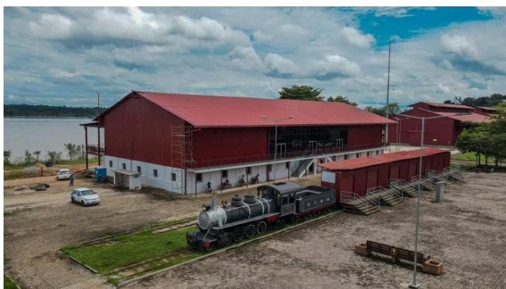
Figura 35: Imagem externa do museu itinerário da ferrovia
