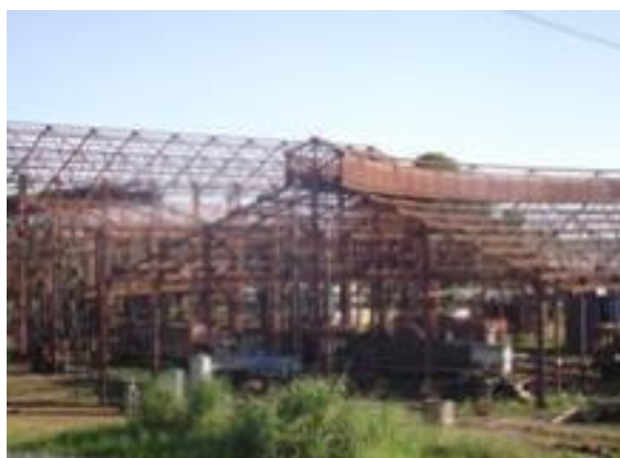
Figura 49: Imagem da oficina ferroviário em construção
