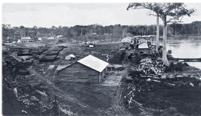
Figura 7: Obra da EFMM
