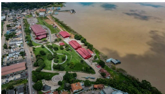
Figura 52: Imagem espacial do pátio ferroviário
