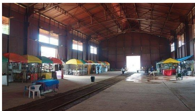
Figura 34: Imagem da parte interna do galpão antes da reforma
