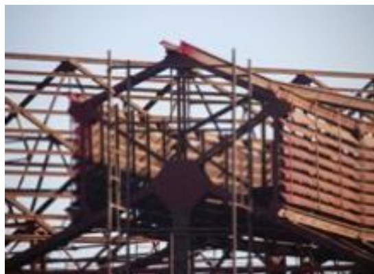
Figura 48: Imagem da oficina ferroviário em construção
