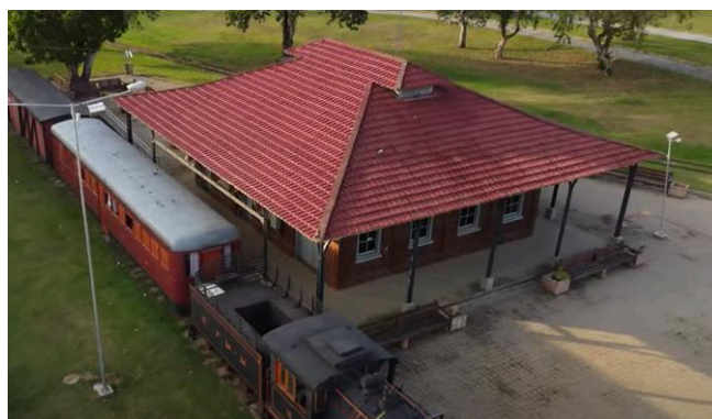
Figura 42: Imagem da cobertura da estação.
