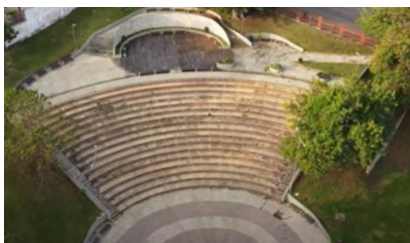
Figura 57: Vista espacial dos degraus do Anfiteatro
