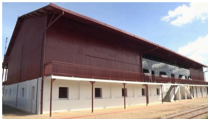
Figura 20: Estrada de Ferro Madeira Mamoré em Porto Velho em dezembro de 2020, após obras
