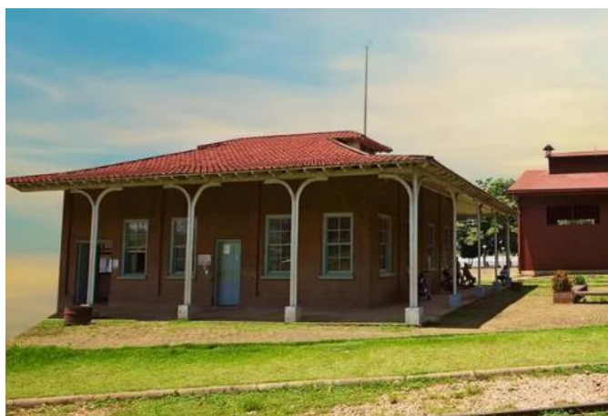
Figura 41: Imagem externa da estação.
