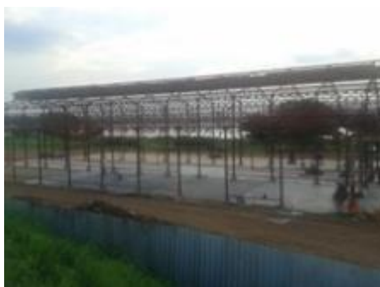
Figura 50: Imagem da oficina ferroviário em construção
